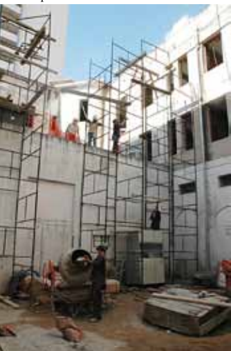
Detalhe das obras de restauro
