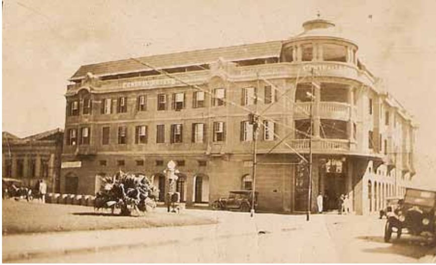
Central Hotel, depois Palace Hotel, em foto provavelmente tirada entre 1926 e 1928, quando o prédio ainda era propriedade do comerciante de café, Adalberto Henrique de Oliveira Roxo. Abaixo, foto do hotel, em 1935, já com as alterações feitas pelo arquiteto Hipollyto Gustavo Pujol Junior. Ali, já é possível perceber a presença do Theatro Pedro II, construído após a derrubada do Hotel Central
