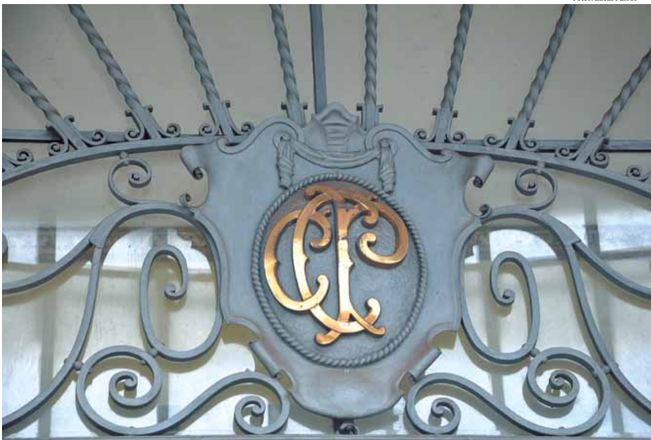
Acima: detalhe da porta de entrada do Palace; abaixo, à esquerda, escadas no pátio interno; à direita, detalhe do piso, com as marcações que indicam a localização e dimensão dos antigos cômodos
